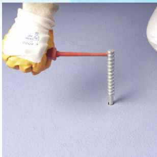
Bohrkernverankerung spannen
